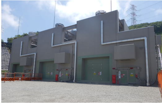
ガスタービン発電機建物外観
