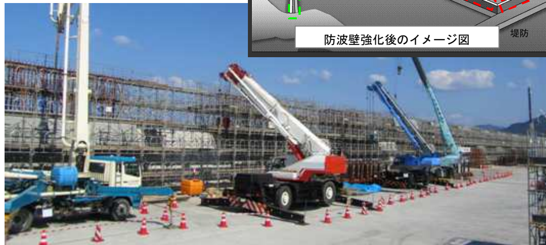
3号機北側エリアの防波壁工事の様子
