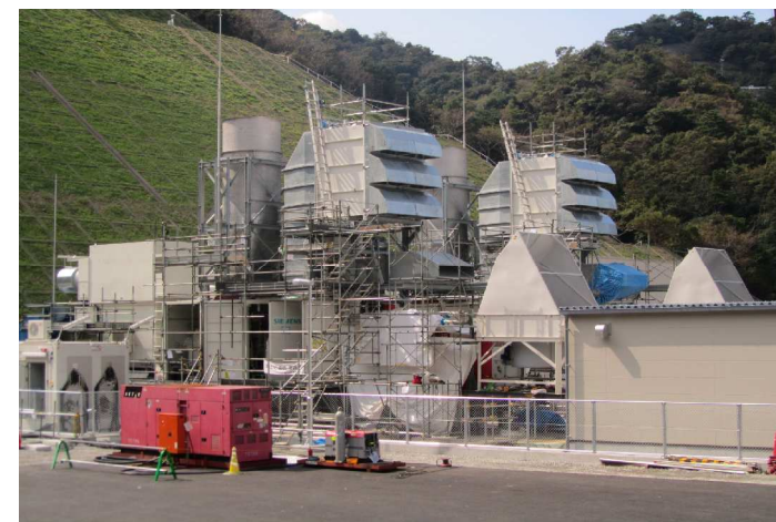
ガスタービン発電機 設置工事の様子
