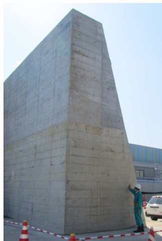
コンクリート打設後の防波壁
