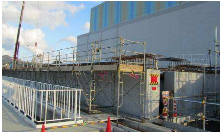
3号機海水系ポンプエリア 防水蓋基礎工事状況
