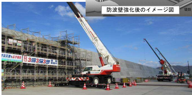
防波壁3号機北側エリア工事状況
