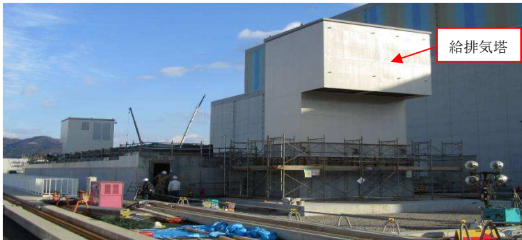
3号機海水系ポンプエリア工事状況
