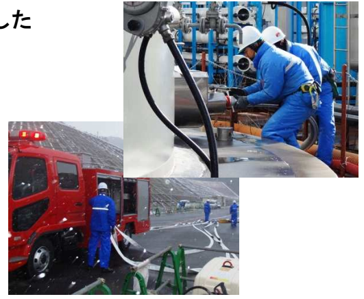
純水タンク（水源）と消防車両等を用いた原子炉注水訓練
