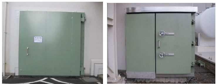
1号機建物外壁に設置した水密扉
