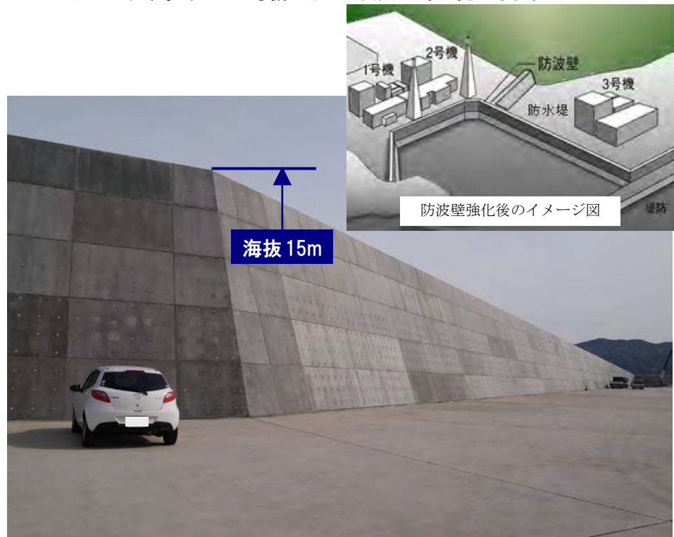
3号機北側の防波壁
