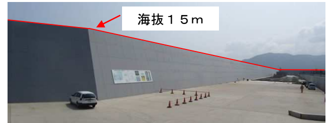
3号機エリア（工事終了）
