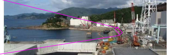
1, 2号機エリア（工事中）
