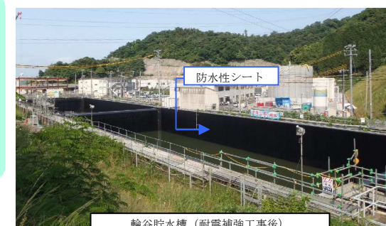
輪谷貯水槽耐震補強工事の状況
