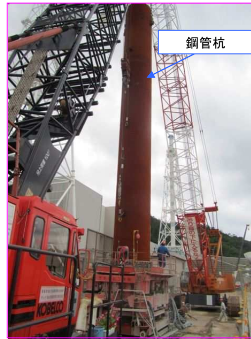
鋼管杭建込み工事の状況
