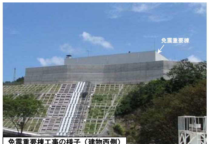
免震重要棟工事の様子（建物西側）
