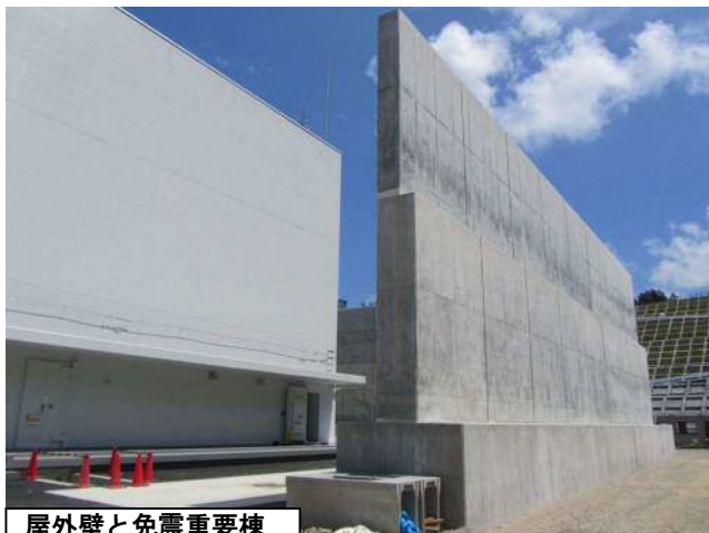
屋外壁と免震重要棟
