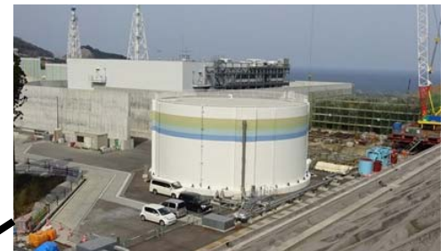
非常用ろ過水タンク
