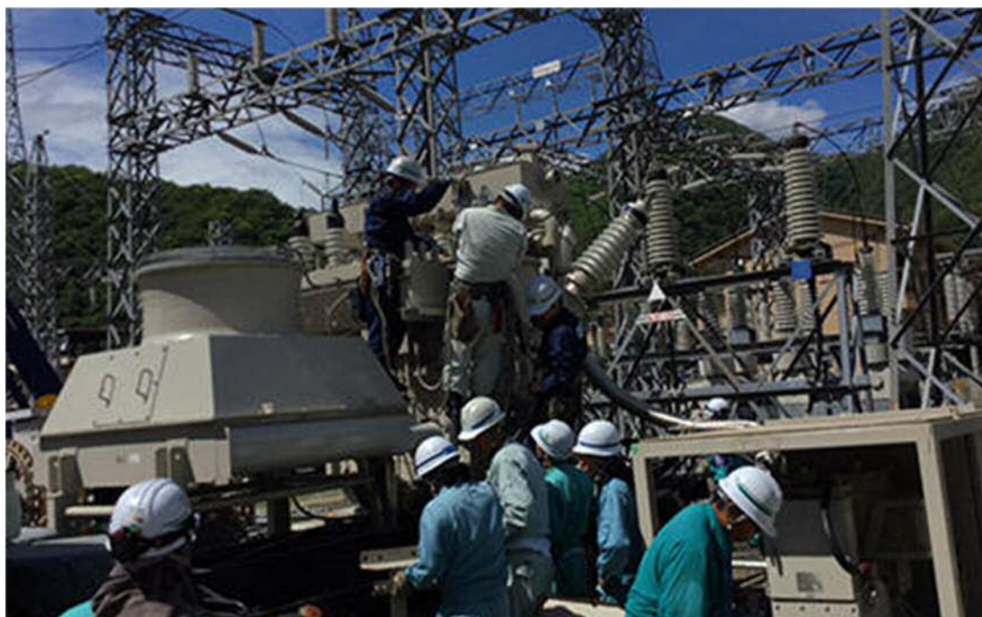
<復旧作業中の成羽変電所（岡山県高梁市）>
