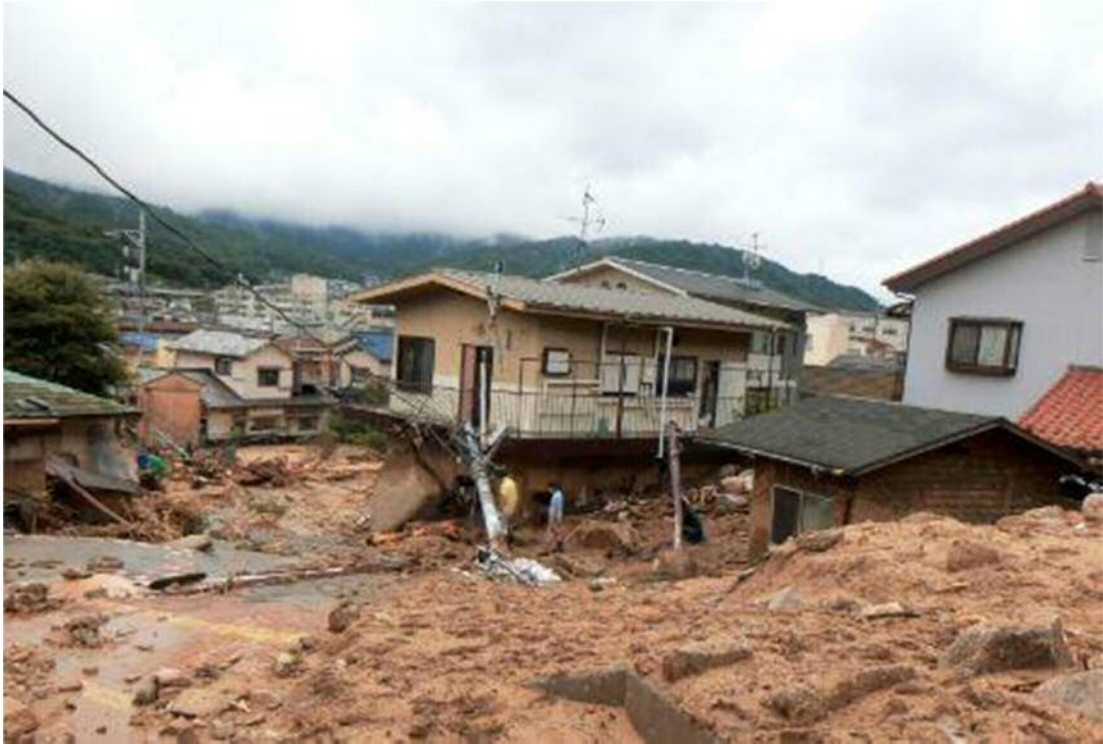
<倒壊した電柱①（広島県広島市安芸区）>
