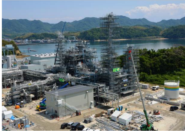
写真一 大崎クールジェンCO 2 分離・回収設備（建設中）
