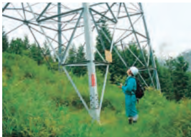
徒歩巡視で鉄塔を目視点検
