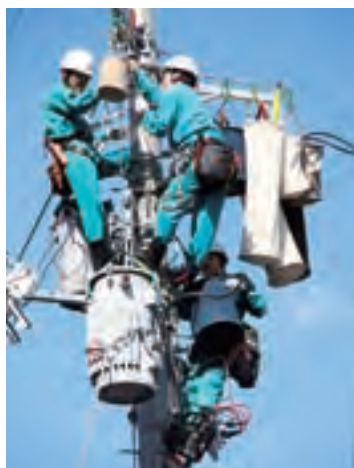
高所作業車を使用しない変圧器吊替作業訓練
