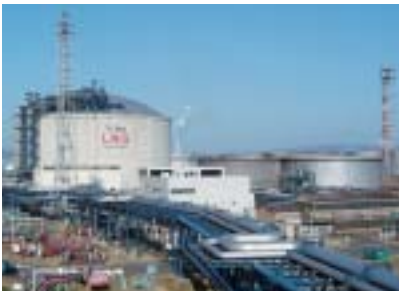
Mizushima LNG Station
