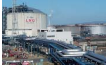
Mizushima LNG Station
