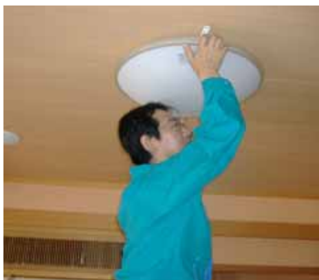
(総合福祉施設での照明設備清掃)
