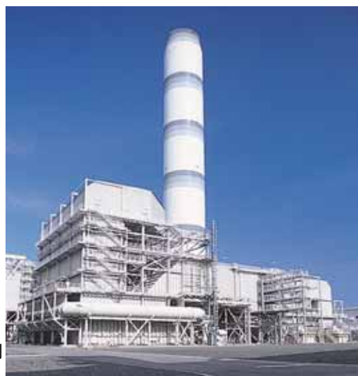
(脱硫装置と煙突)
