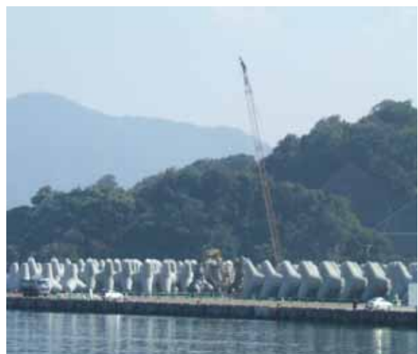
(石炭灰を利用した80t消波ブロック)
