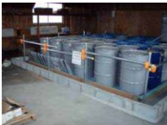
ドラム缶へ入れて、倉庫内で保管している例
