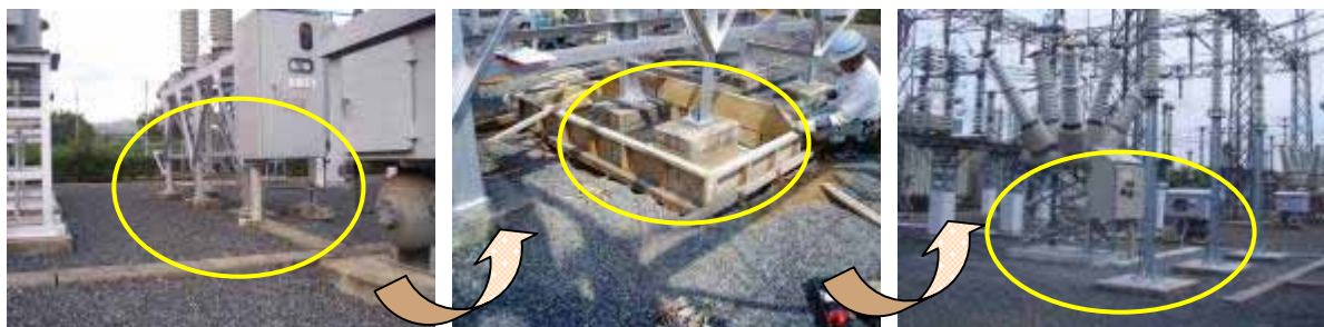
取替前の基礎
