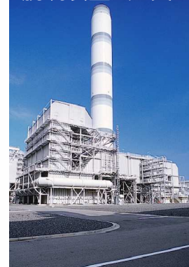
脱硫装置と煙突
