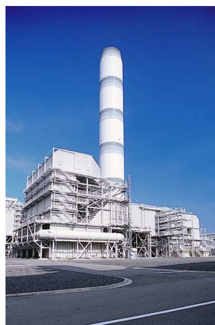
脱硫装置と煙突
