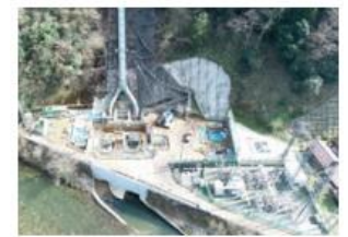
北原発電所の改修工事 (発電所出力：15,600kW→17,700kW)
