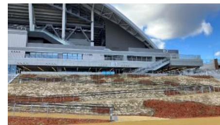
サッカースタジアム（広島市）の北東側スロープの人工土に採用（ライトサンド）
