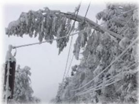
設備被害状況
