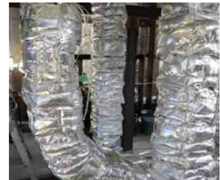
耐火ラッピングの固定状況
