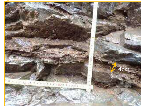
凝灰岩露頭 割れ目密集帯の厚さ4cm
