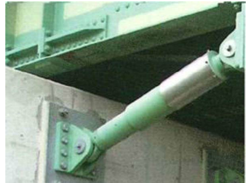
単軸粘性ダンパの外観（橋梁への設置例）
