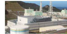
宿直場所：免震重要棟
