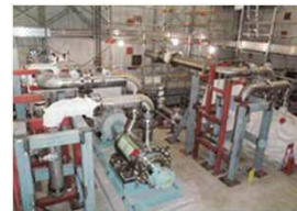
低圧原子炉代替注水ポンプ
