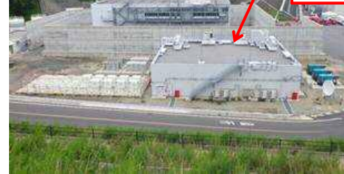
緊急時対策所
