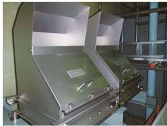
静的触媒式水素処理装置
