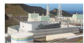
宿直場所：免震重要棟
