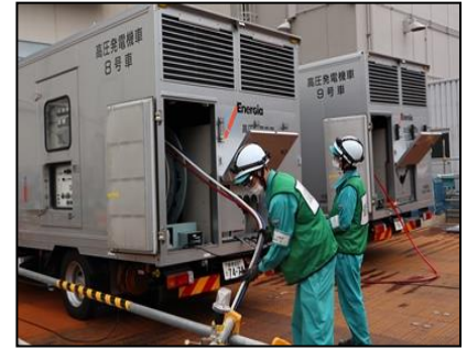
高圧発電機車を用いた現場訓練
