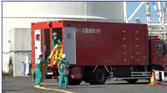
注水のためのホース展張作業
