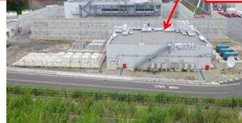
緊急時対策所
