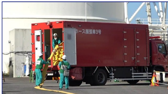
注水のためのホース展張作業
