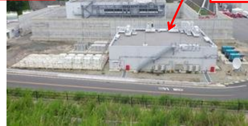
緊急時対策所
