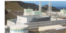
宿直場所：免震重要棟
