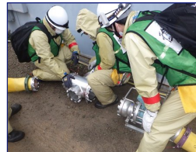
電源確保のためのケーブル繋ぎ込み作業
