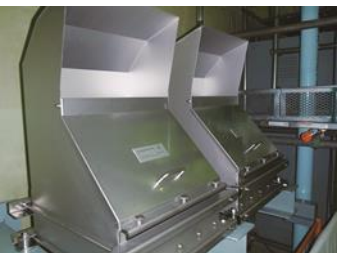
静的触媒式水素処理装置
