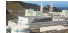
宿直場所：免震重要棟
