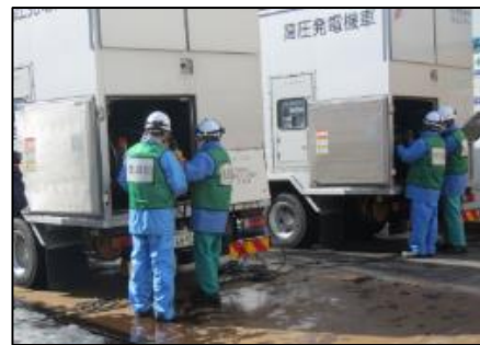
電源確保のための高圧発電機車準備作業
