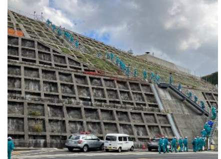
緊急時対策所への移動
