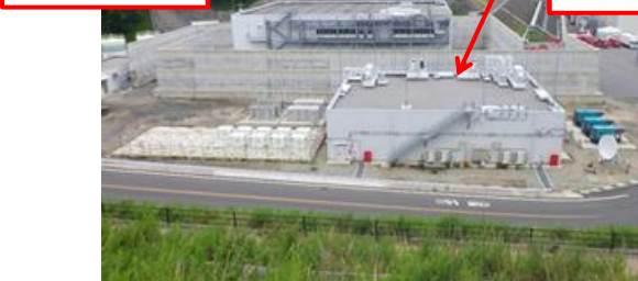
緊急時対策所
