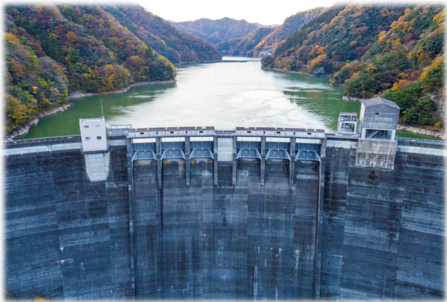
新成羽川ダム（岡山県 備中町）
