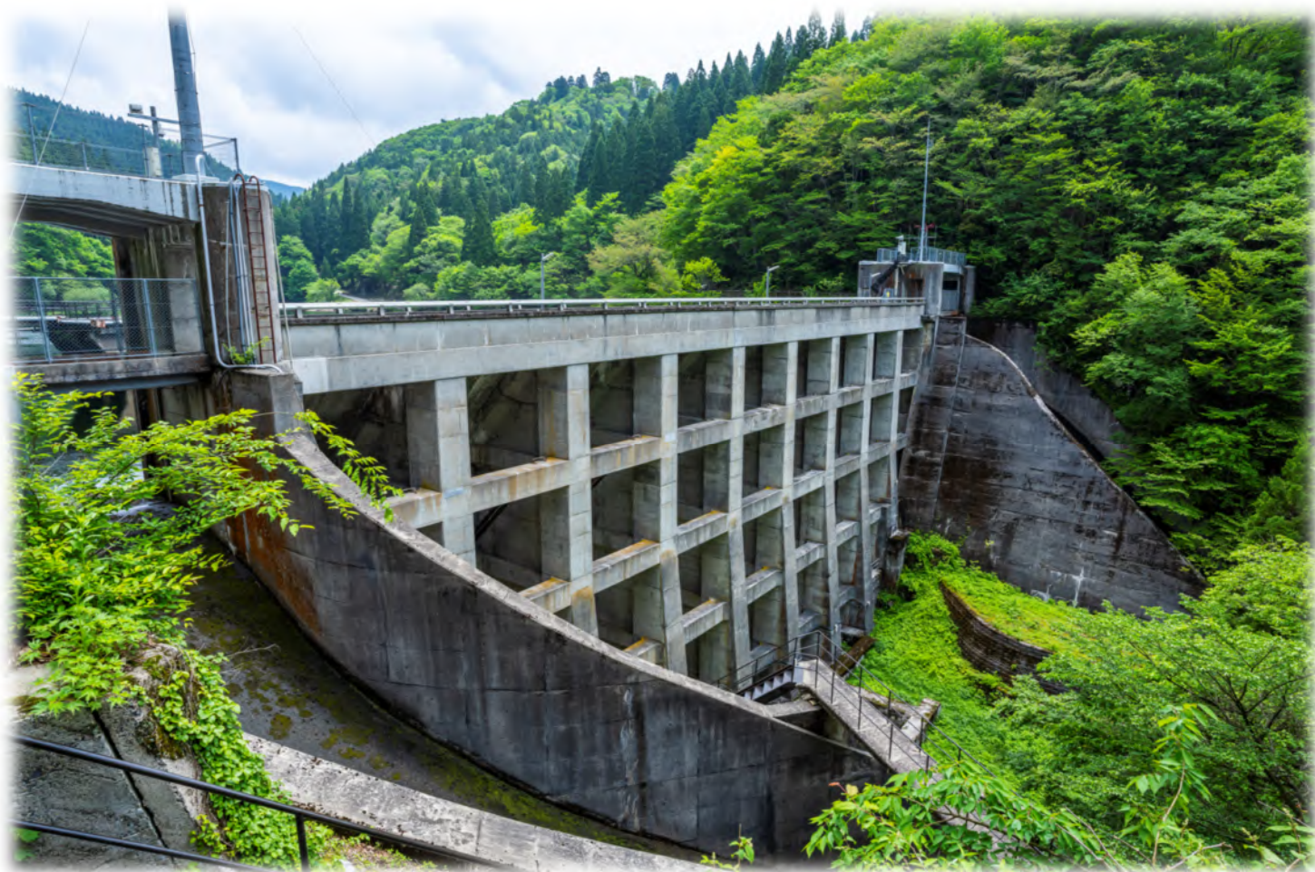
三滝ダム（鳥取県 八頭郡 智頭町）
