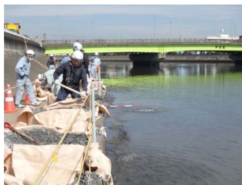
石炭灰造粒物敷設状況（小規模施工） （関東地方での活用事例：1級河川鶴見川）
