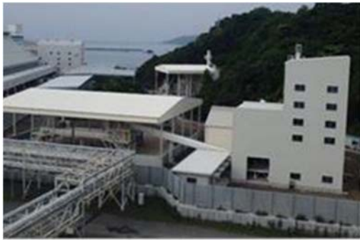
石炭灰造粒物の製造設備 （製造能力 6 万 m 3 /年） （三隅発電所構内：島根県浜田市）
