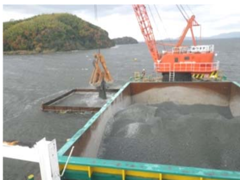
起重機船での石炭灰造粒物敷設状況（大規模施工） （中国地方閉鎖性水域での活用事例：中海）
