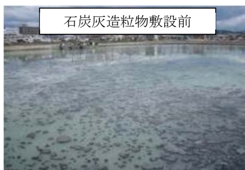
浮泥大量発生（悪臭発生）時の状況 （福山港内港（瀬戸内海）での事例）
