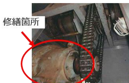
取水口除塵機部分修繕（駆動装置）
