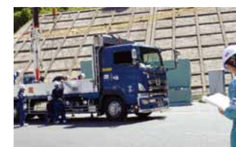
クレーン作業を観察している様子
