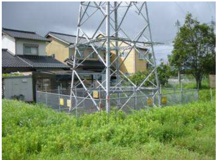
盛土高：約 2 m，鉄塔脚との離隔：約 5 m
