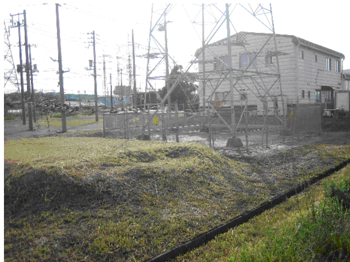
盛土高：約 1 m，鉄塔脚との離隔：約 5 m
