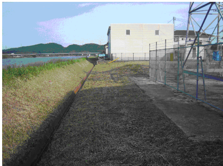
盛土高：約 1 m，鉄塔脚との離隔：約 8 m
