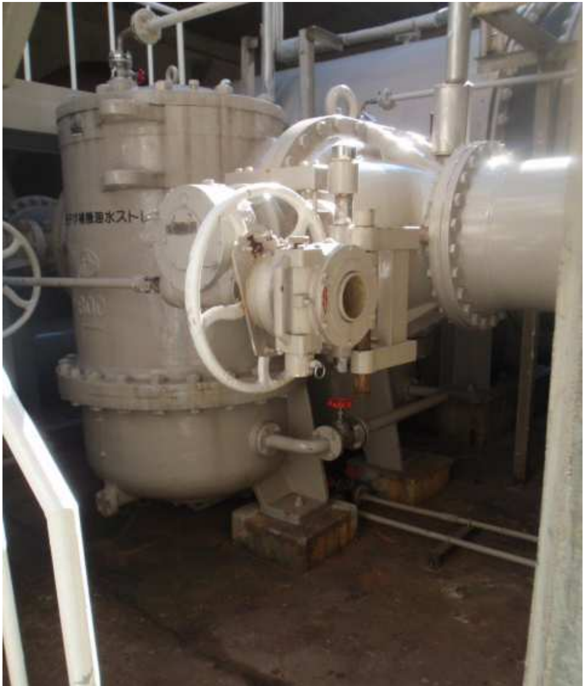
【原子炉補機海水ストレーナ】
