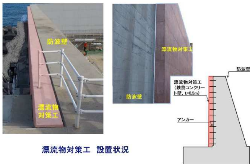
図1 漂流物対策工の設置状況
