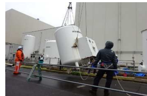
撤去作業の状況
