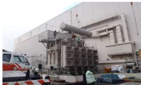
撤去作業の状況
