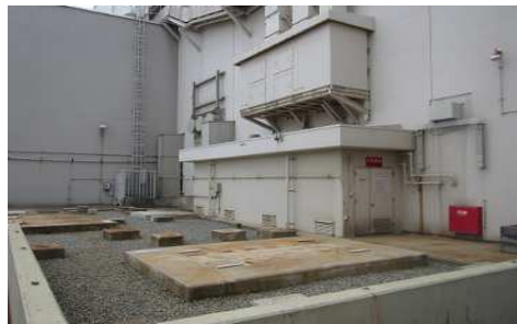
撤去作業後の状況
