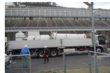
解体物の移送
