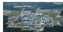
日本原燃(株)再処理工場※2 (平成30年度上期竣工予定)
