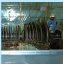
周辺設備の解体
