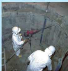
原子炉の周囲にある施設の解体
