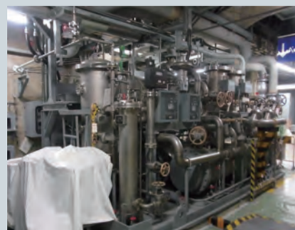
固定子冷却設備*
