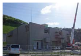
ガスタービン発電機設置工事状況 (平成29年4月)
