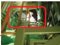
平成28年12月8日に確認した腐食孔 (約100cm×約30cm)
