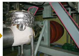
耐震補強工事後
