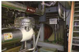
耐震補強工事前
