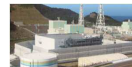
宿直場所：免震重要棟
