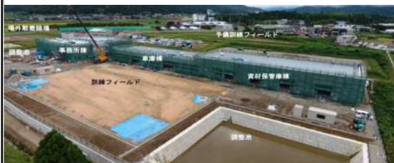
現地工事進捗状況（平成28年9月27日）
