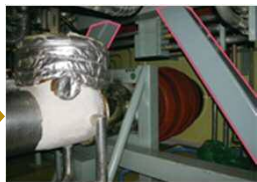
耐震補強工事後
