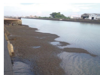
福山港内港で造成した干潟
