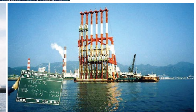
大竹地区埋立地SD工事 SD施工状況
