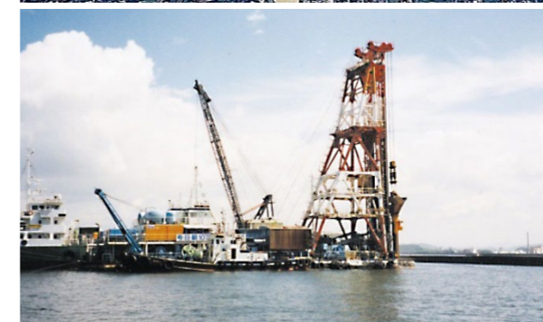
小野田港防波堤、刈屋漁港工事 SCP施工状況
