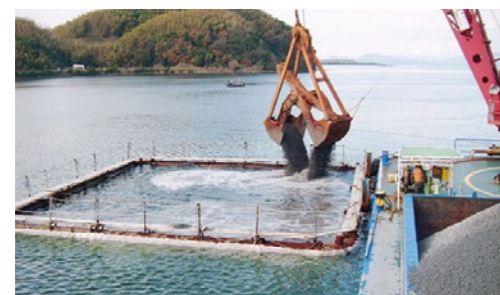
埋め戻し工事施工状況
