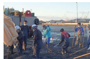
干潟造成の工事状況
