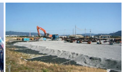
埋立地敷砂(重機作業床)
