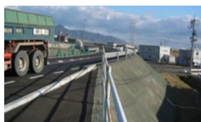
出雲バイパス改良工事 法面にライトサンドを使用
