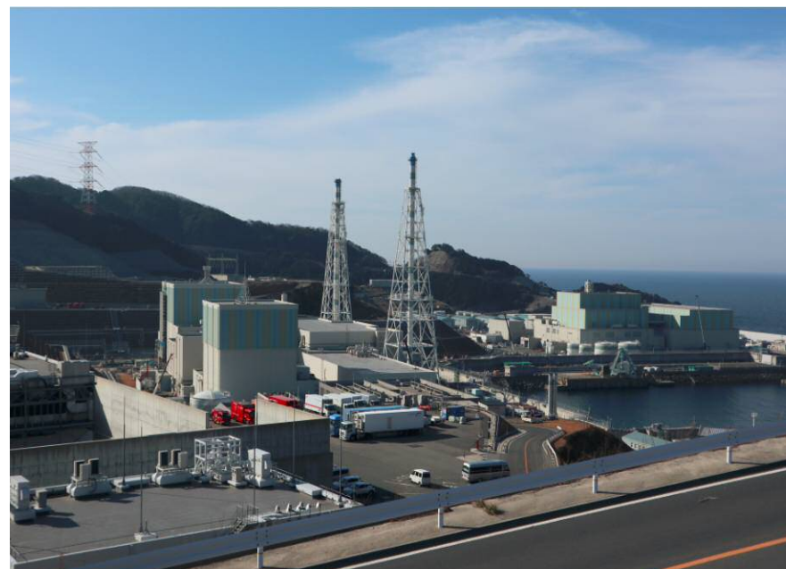
〔島根原子力発電所〕
