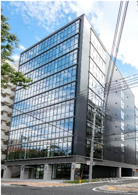
エネプレイス岡山（建物外観）
