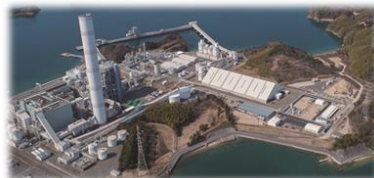
大崎クールジェンプロジェクト 実証試験設備
