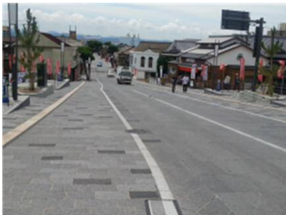
出雲大社前交差点側から見る神門通り。人通りの多い交差点近くは歩道が広くなり、店舗もセットバックしたため、従前より歩行者空間が広がっている。
