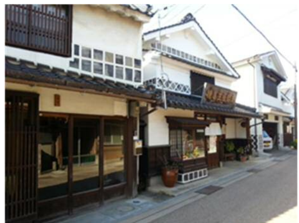
切妻・妻入り塗り家造りの伝統的建造物群（出雲市平田町）
